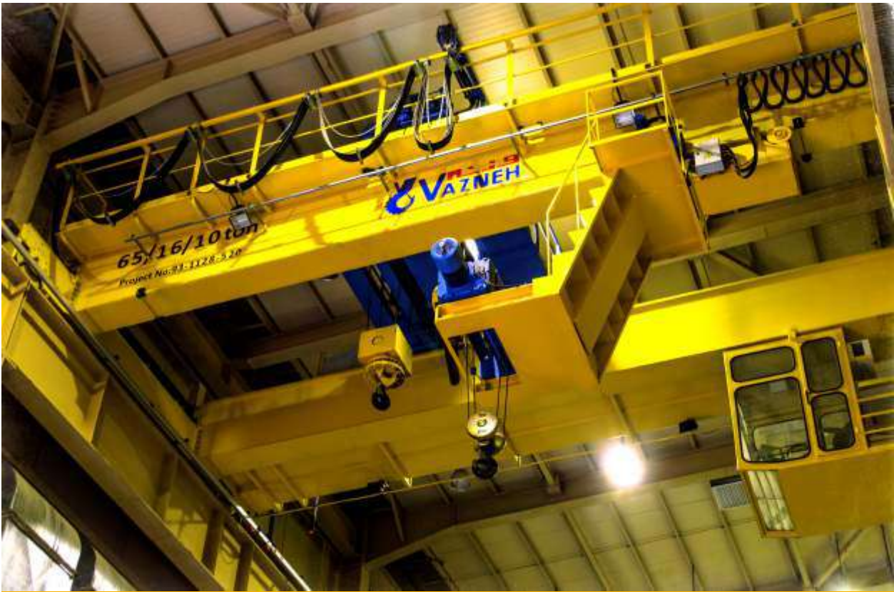
جرثقیل نیروگاه سیکل ترکیبی مپنا کهنوج
